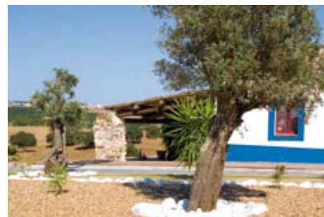
Neue Gästehäuser inmitten Olivenhainen
