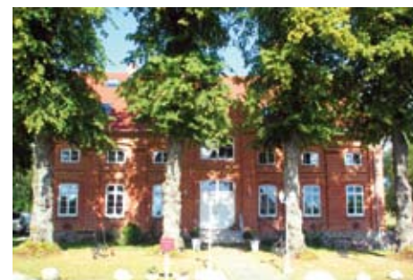
Das Gutshaus auf Rügen
